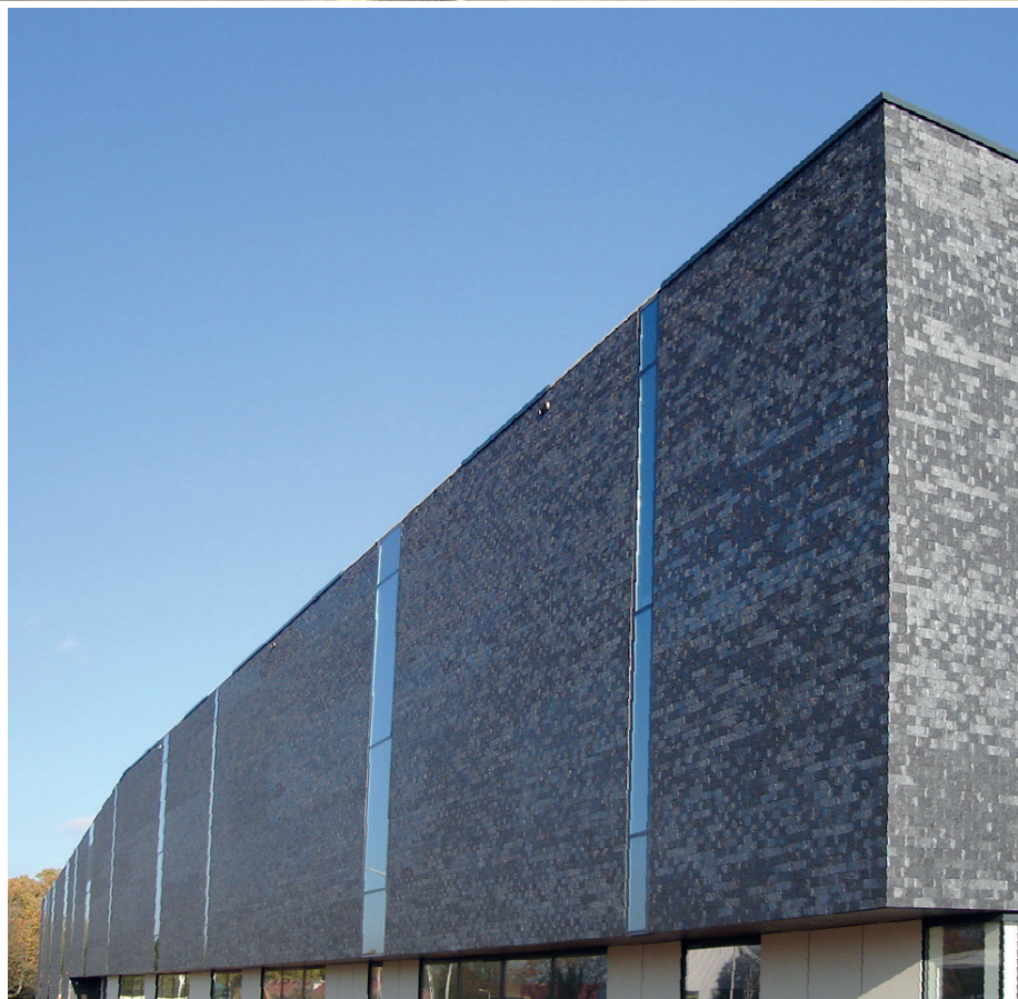
Фасад ClickBrick до переделки, для которой пришлось удалить 18 000 камней.
